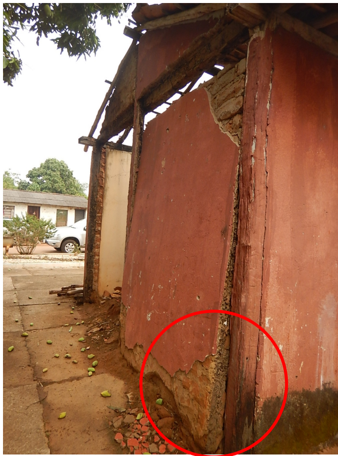
Figura 8: Registro Posto Telegráfico - Detalhe do deslocamento
