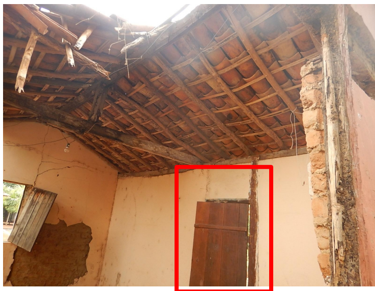
Figura 4: Registro Posto Telegráfico - Vista da Porta
