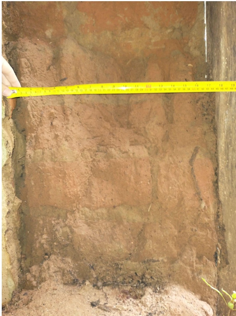
Figura 16: Registro Posto Telegráfico - Desagregação de material
