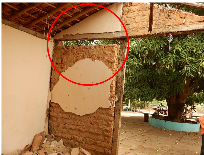
Figura 9: Registro Posto Telegráfico - Detalhe do deslocamento
