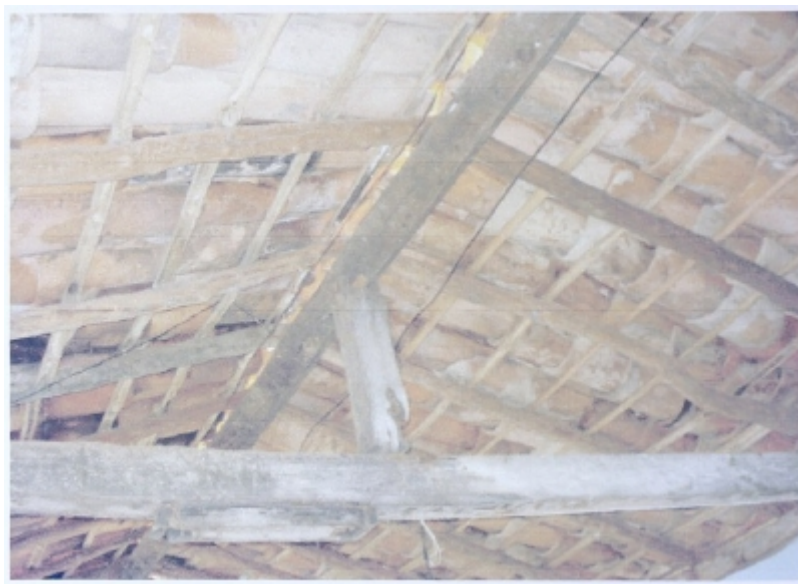
Figura 2: Registro Posto Telegráfico - Trama do Telhado
