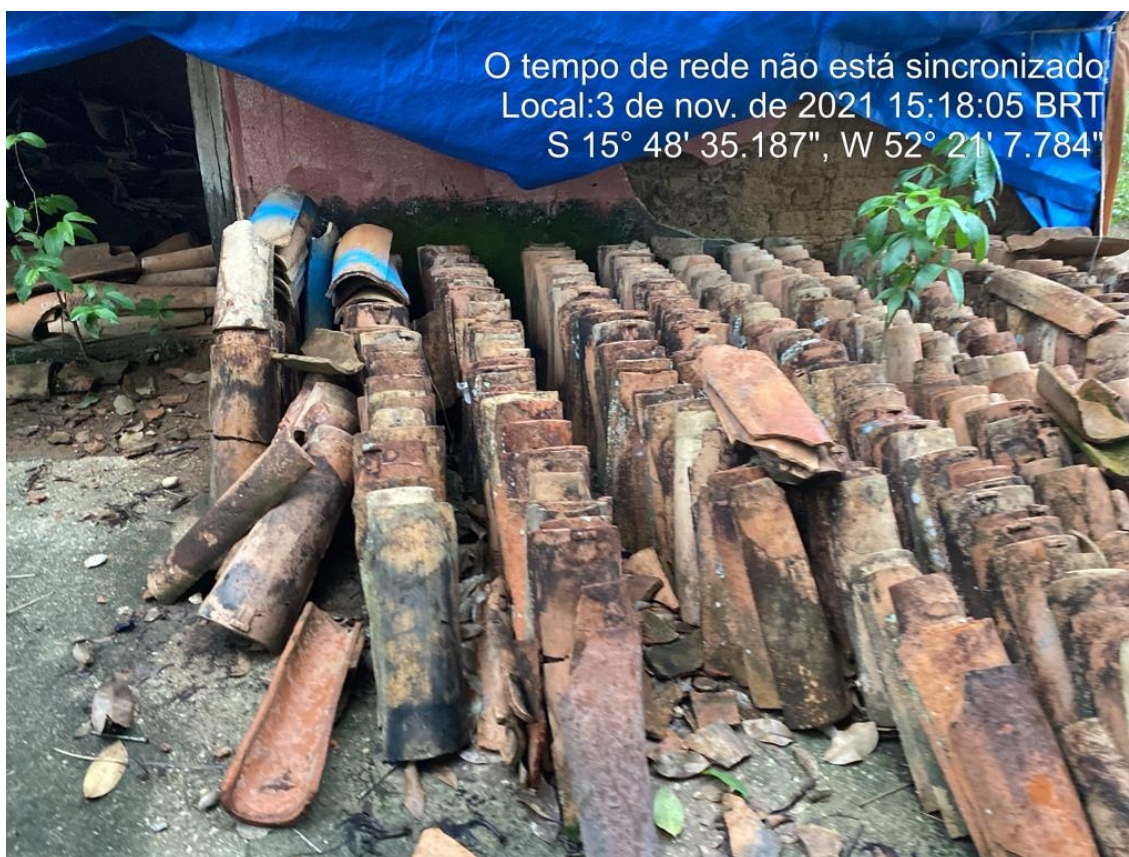
Figura 21: Registro Posto Telegráfico - Telhas do tipo capa-canal.
