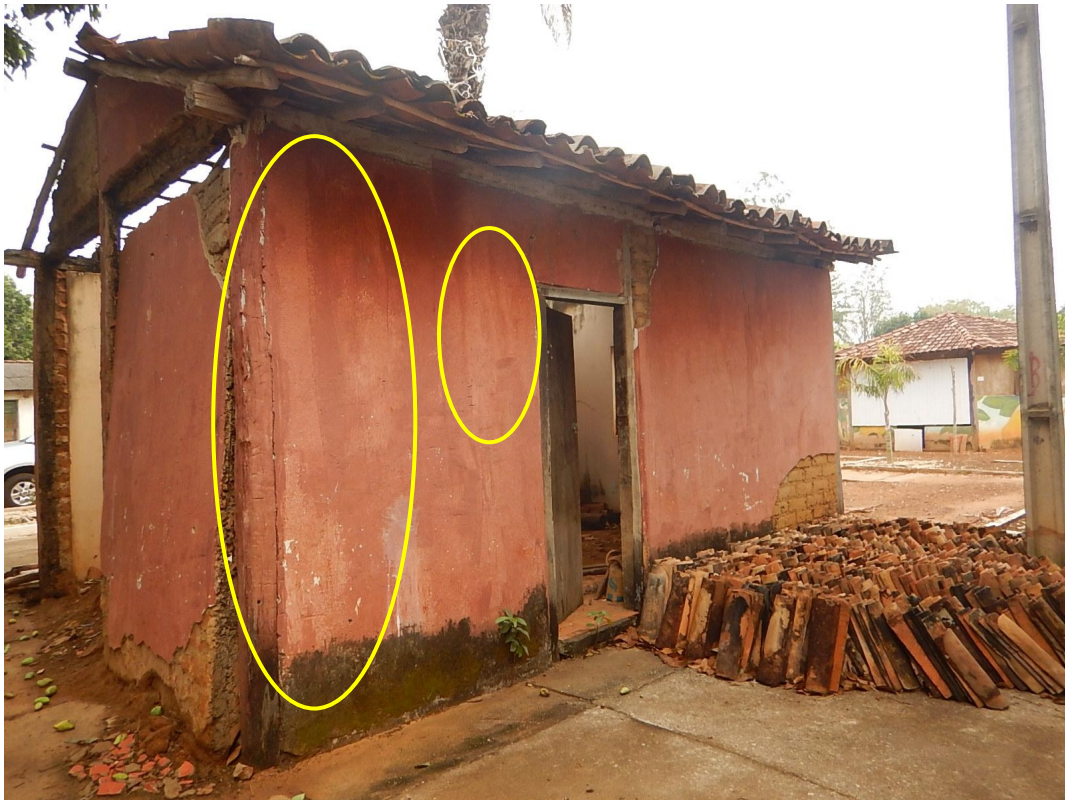
Figura 12: Registro Posto Telegráfico - Possível processo de calcinação
