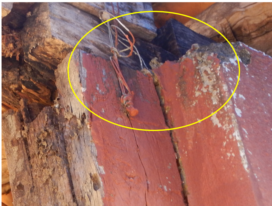
Figura 15: Registro Posto Telegráfico - Característica membranácea da tinta utilizada
