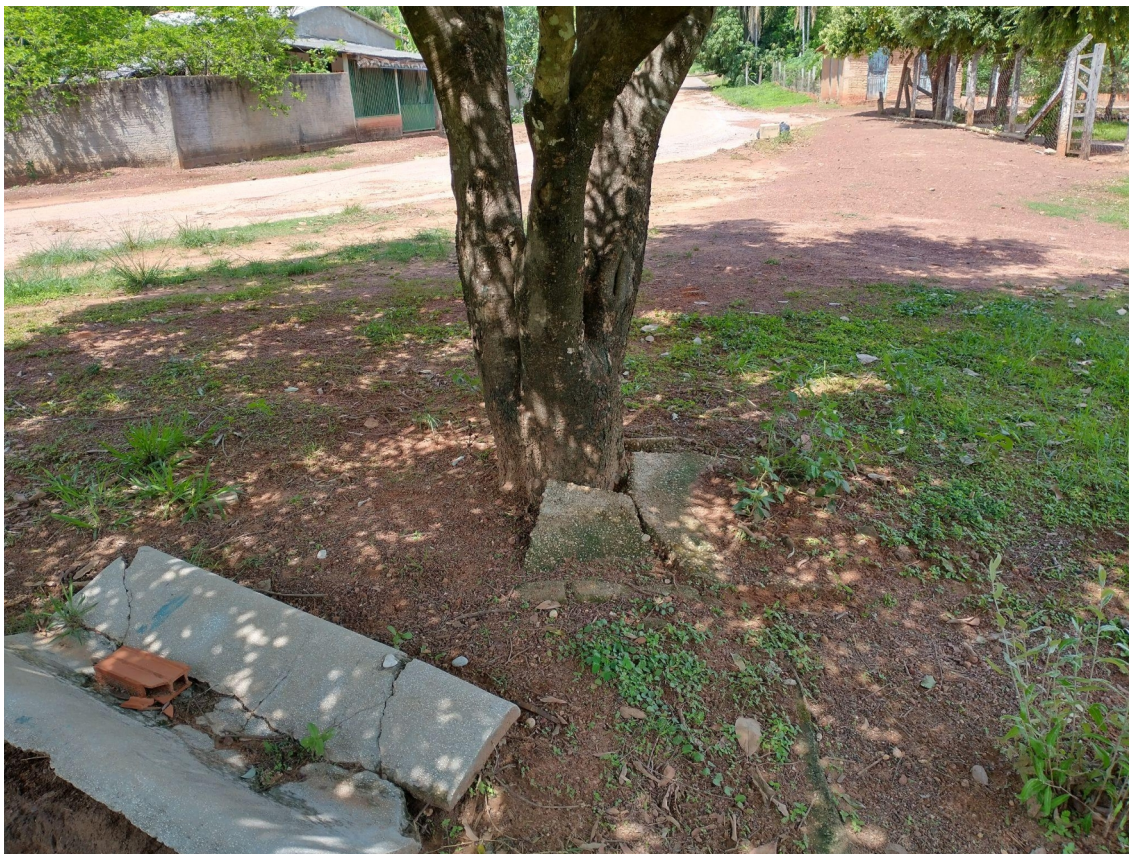
Figura 37: Escombros de banco de concreto
