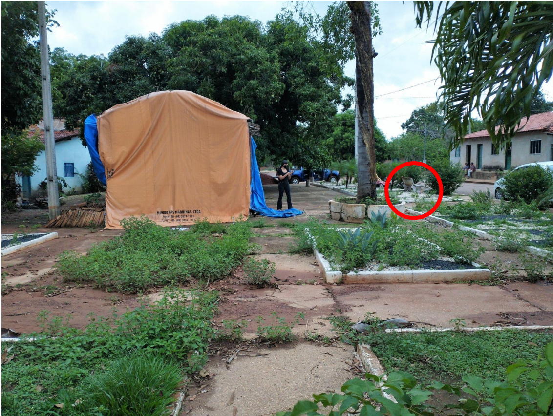
Figura 36: Banco de concreto existente
