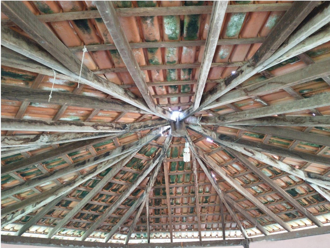
Figura 35: Trama do telhamento do coreto
