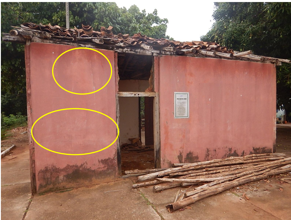
Figura 12: Registro Posto Telegráfico - Possível processo de calcinação
