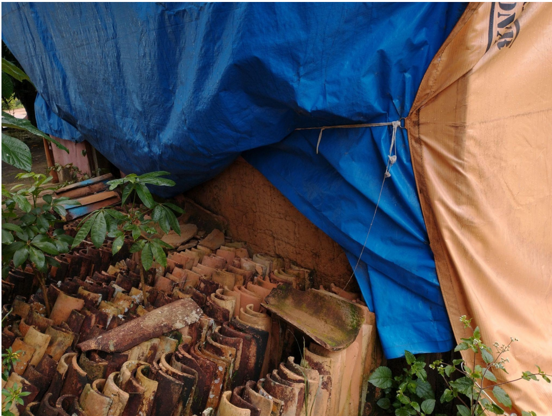
Figura 20: Registro Posto Telegráfico - Telhas do tipo capa-canal.
