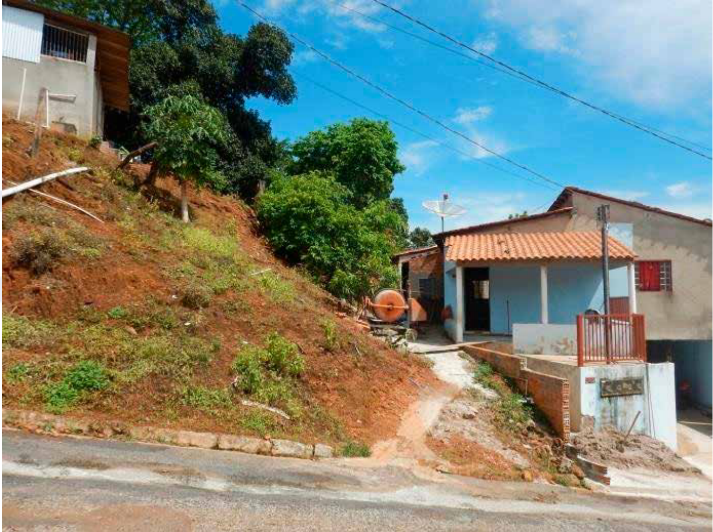
Figura 21 - Visualização dos cortes de talude e aterro lançado e a proximidade das moradias. Fonte: CPRM, (2018).
