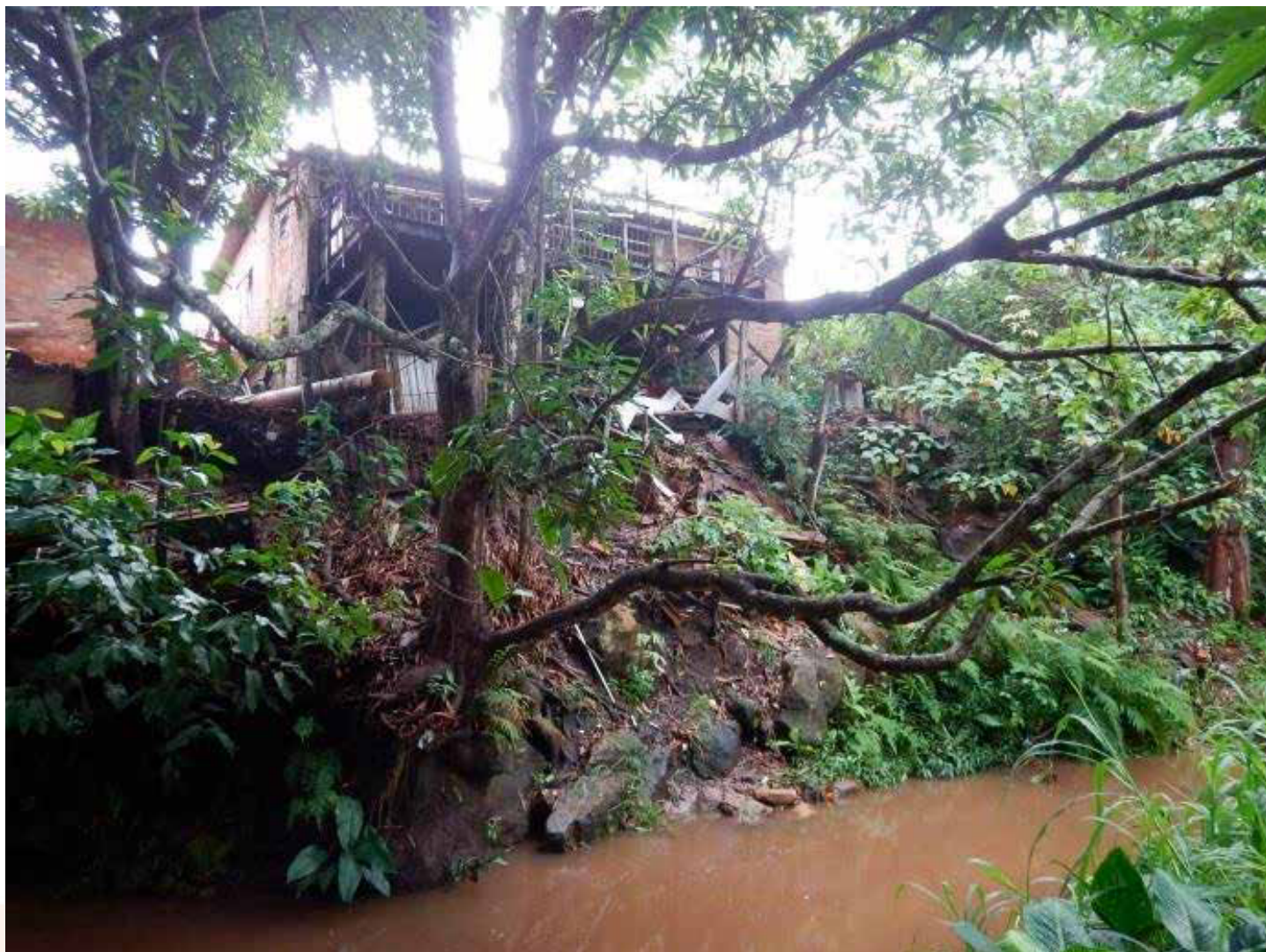
Figura 11 - Moradia em margem sujeita a solapamento com aterro lançado e resíduos Fonte: CPRM , (2018).
