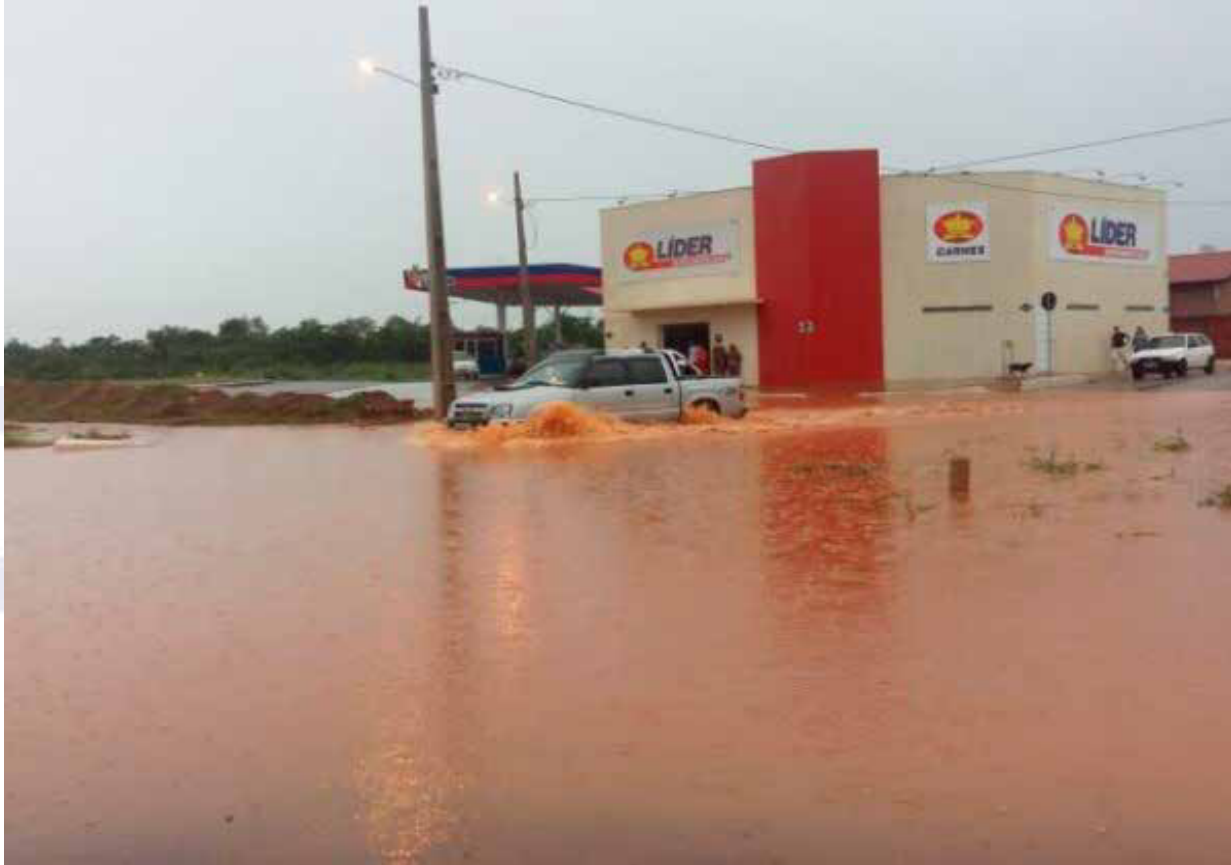
Figura 07 - Alagamentos em dias de chuvas intensas Av. Amazonas Fonte: Borges, (2020).
