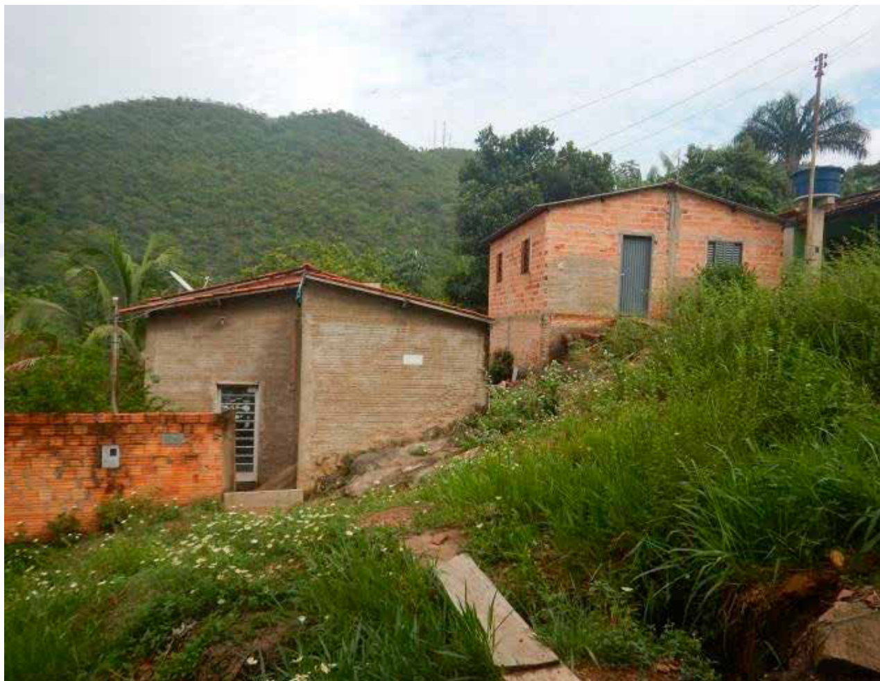
Figura 12 - Moradias em corte de talude e aterro. Fonte: CPRM e DEGET, (2018).
