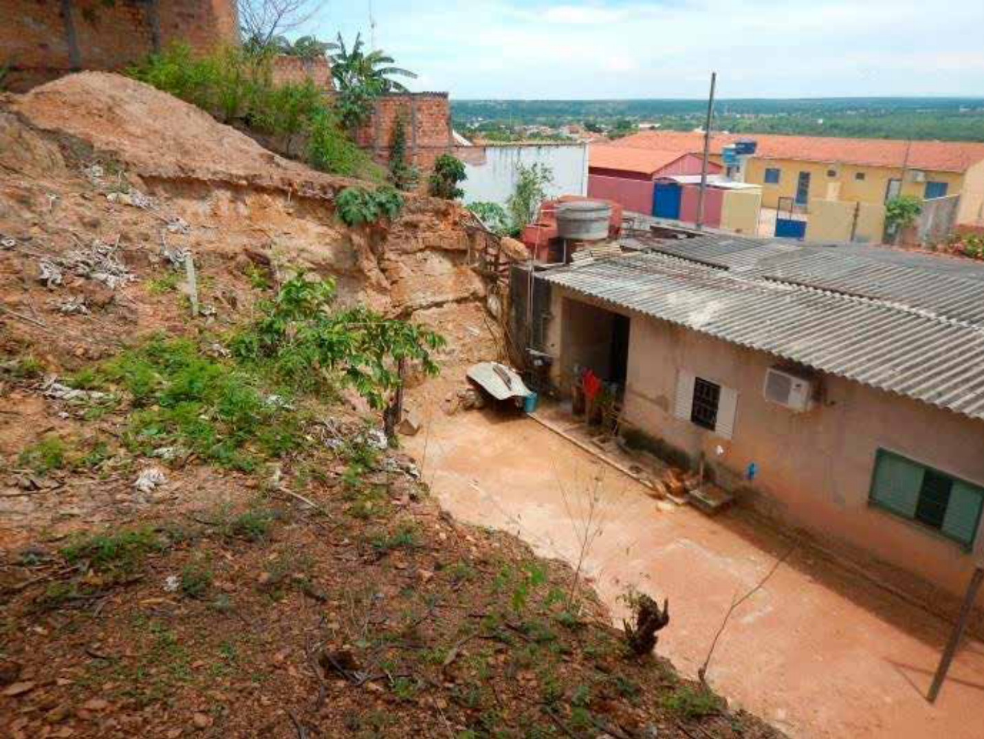
Figura 20 - Corte e encosta próximas a residências. Fonte: CPRM, (2018).
