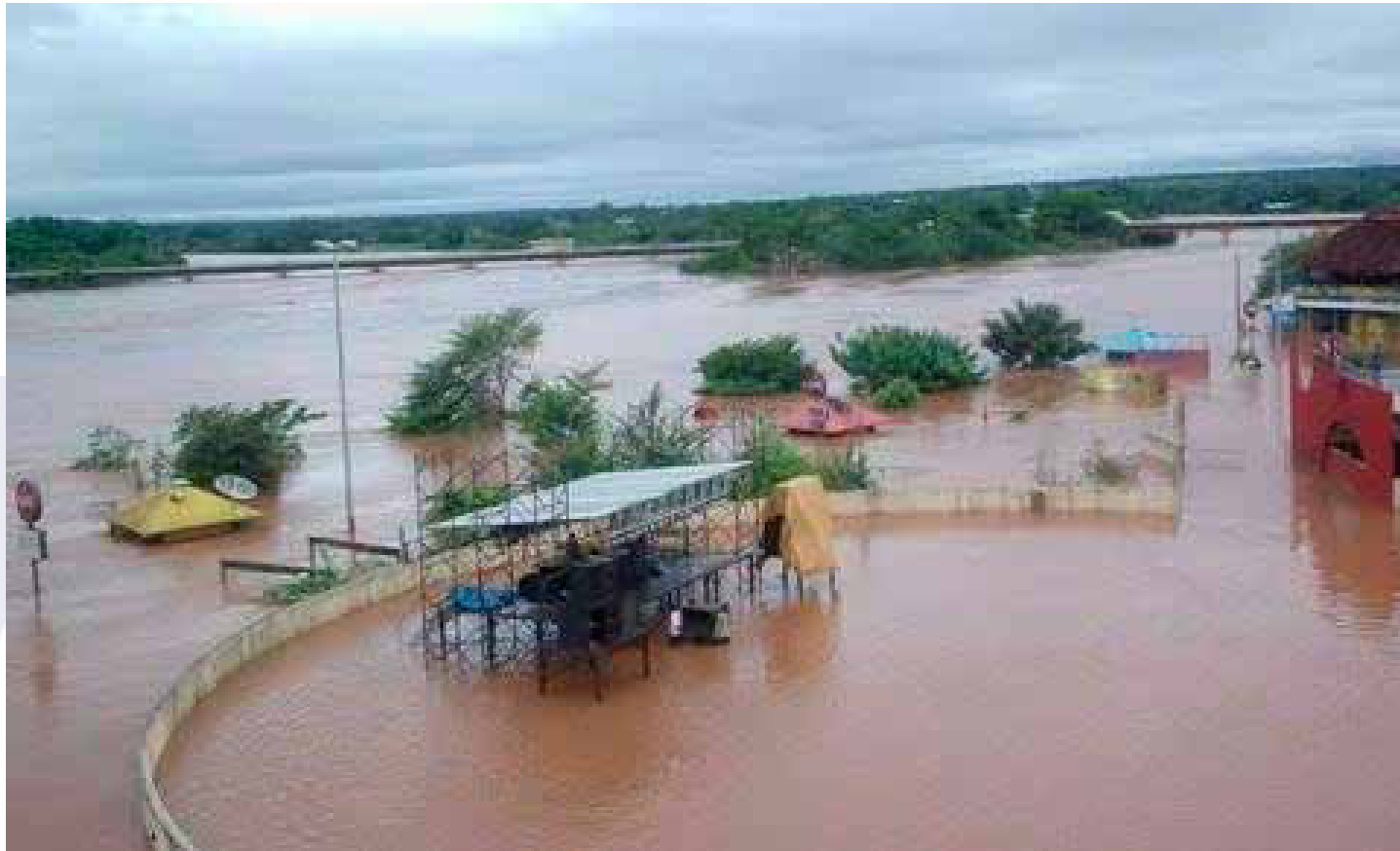
Figura 06 - Inundação margem Rio Araguaia localizado no Porto do Báe Fonte: Borges, (2020).
